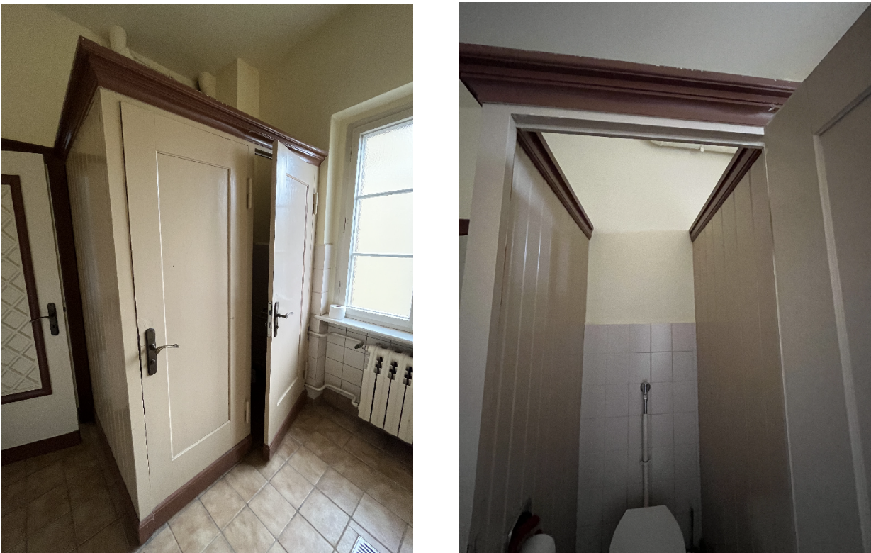
WC Trennwände Bestand b x t x h = 1,68 x 1,03 x 2,28m
